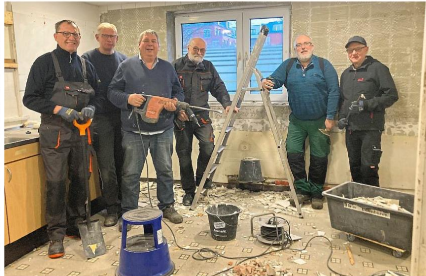
Unter anderem Helmut Rau, Thomas Krömer, Jürgen Schmitz, Karl-Heinz Käsekamp, Uwe Kropf und Josef Breulmann (v.l.) kümmern sich seit Dienstag ehrenamtlich um die Vorbereitungsarbeiten zur Küchenerneuerung im Haus Ibbenbüren auf Wangerooge. Foto: privat
